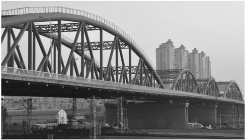
图 1 在役曲弦下承式钢管混凝土桁梁桥
