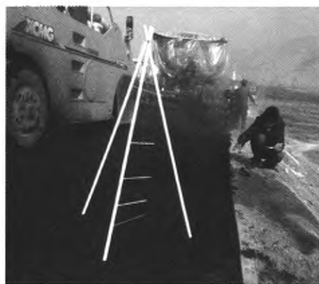
图1 沥青路面摊铺过程中温度场测试
