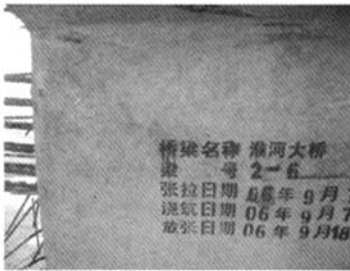
图 8 改进后的箱梁钢绞线锚固区
