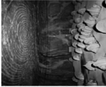
图 10 TBM 掘进硬岩地层时掌心面情况 [23]
