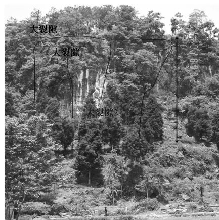
图 2 危岩体裂隙发育示意图
